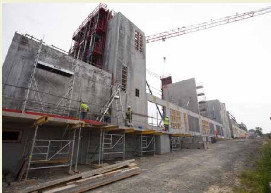
Lycée Simone Veil : un chantier titanesque porté par la Région Bretagne. La ville de Liffré a à sa charge l'aménagement des abords pour un coût estimé à 1 850 000 €
