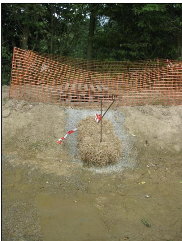
*Photo 13 : Emplacement du filtre à particules fines (botte de paille) pendant la phase des travaux au niveau du bassin d'orage*
