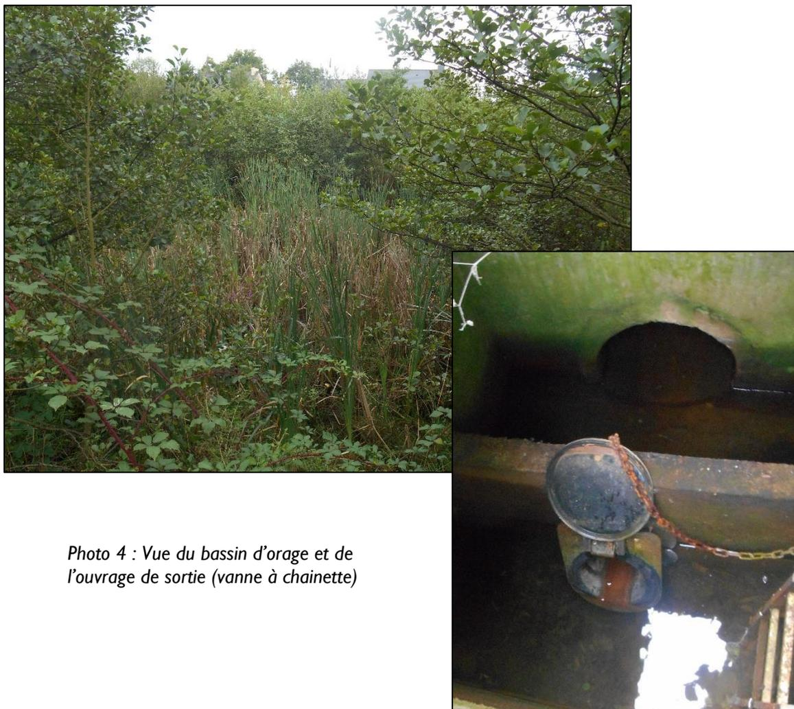
*Photo 4 : Vue du bassin d'orage et de l'ouvrage de sortie (vanne à chaînette)*
