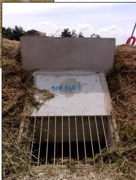
Photo 9 : Vue du bassin d'orage et de l'ouvrage de sortie
