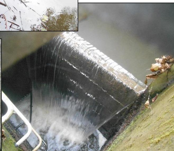
Photo 2 : Vue de l'ouvrage de sortie, de la régulation 300mm et du trop-plein du bassin en eau
